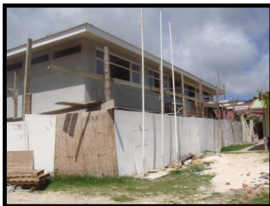
Photo avant du bâtiment en chantier
