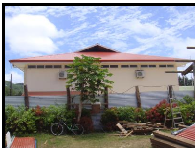
Photo après du bâtiment – travaux achevés
